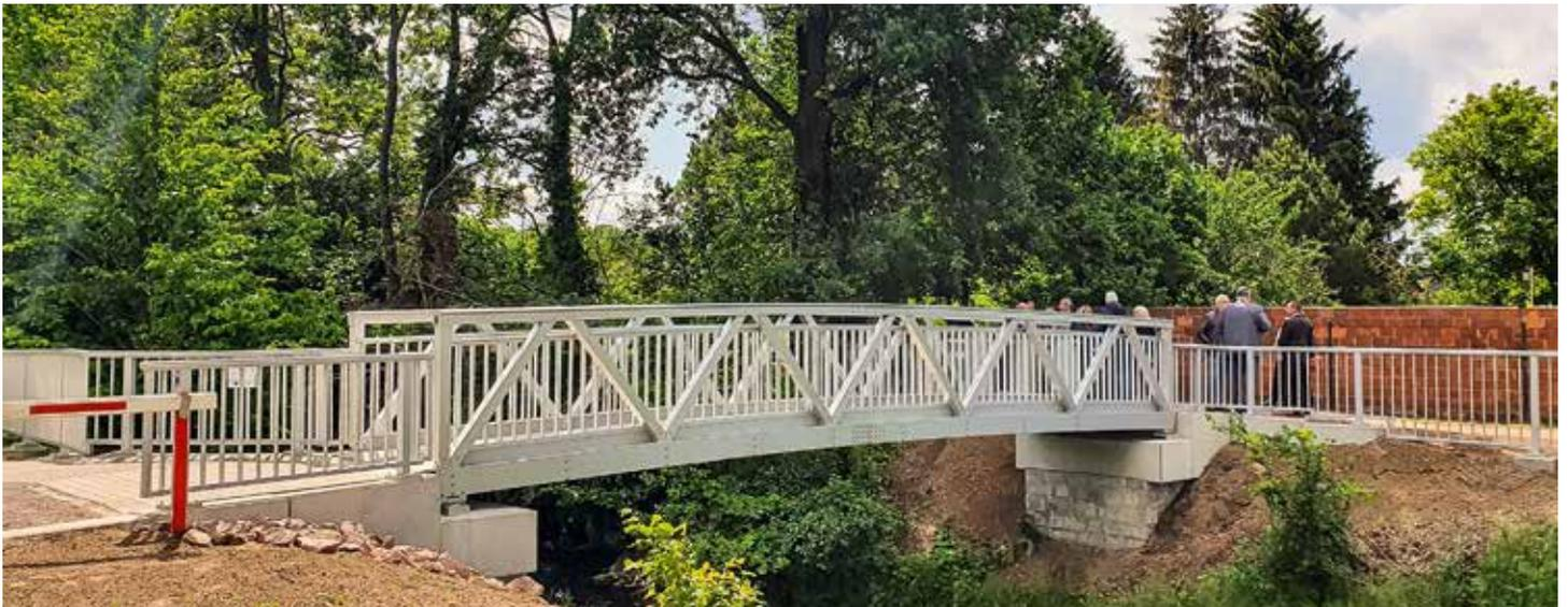
Etwa 11 Meter lang und 2 Meter breit ist die neue Wipperstegbrücke, die komplett aus Aluminium gefertigt ist und nun wieder die Mehringer Ortsteile miteinander fußläufig verbindet.
