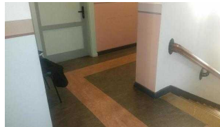
3. OG: Weg vom Aufzug zum Ratssaal
