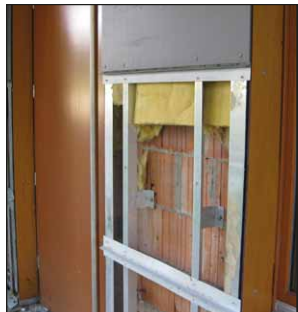
Abb. 6: Vorgehängte hinterlüftete Fassade (© HTW Dresden)
