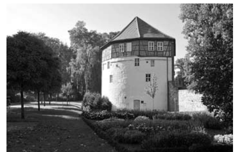
Auch das Rondell am Promenadenring wurde in den 90er Jahren mit Hilfe von Förderprogrammen saniert. Foto: Hielscher
